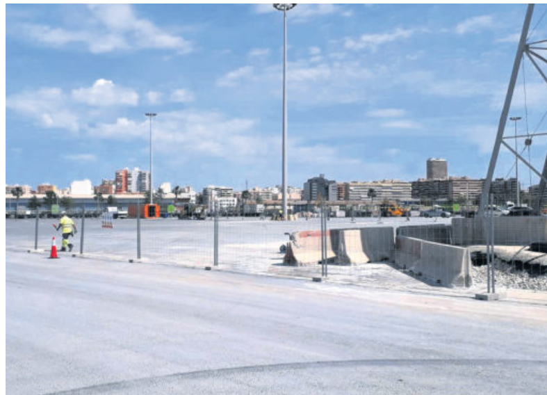
Eiffage ha iniciado las obras en el Muelle 17 del puerto de Alicante.
