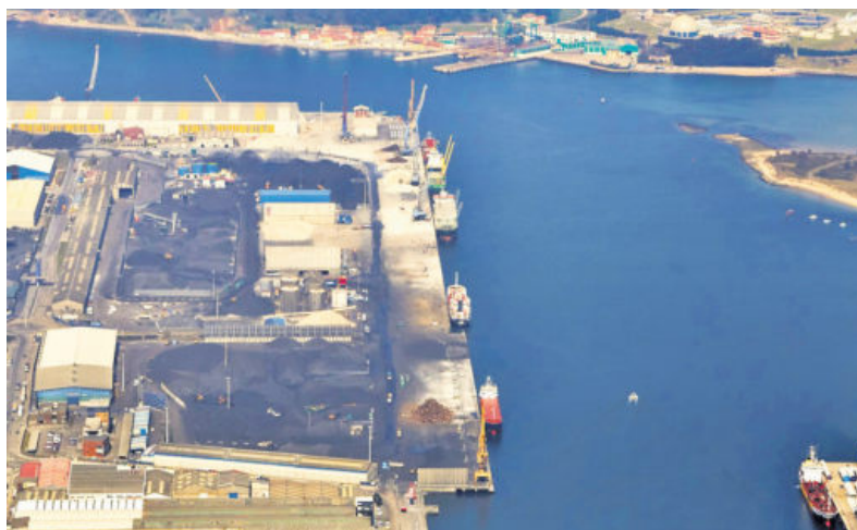
Vista aérea de la zona portuaria de San Juan de Nieva. Foto: Autoridad Portuaria de Avilés.
