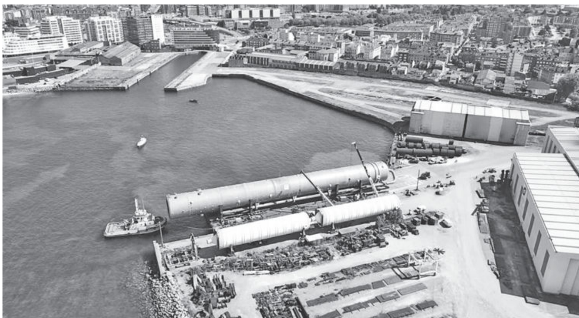
'Project cargo' de Duro Feguera en Gijón. Mammoet, en colaboración con el operador Marprin, traslada una carga pesada de Duro Felguera en Gijón, una de las mayores operaciones del fabricante en su historia, destinada a una planta belga. La pieza, de 1.200 toneladas de peso, tiene 110 metros de largo y 10 metros de diámetro.
