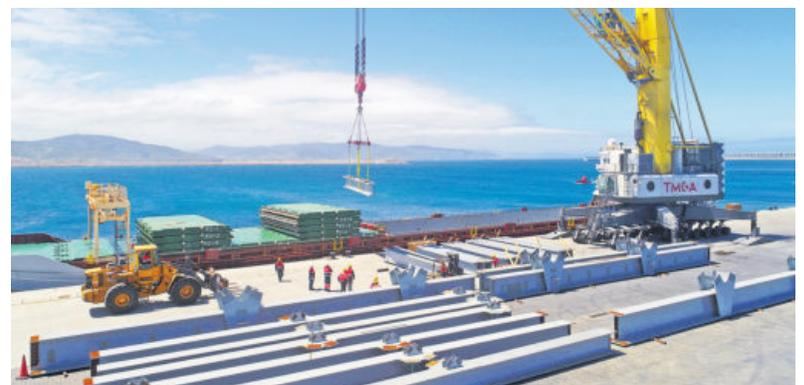
Imagen del embarque de las piezas del puente ferroviario por parte de TMGA.
