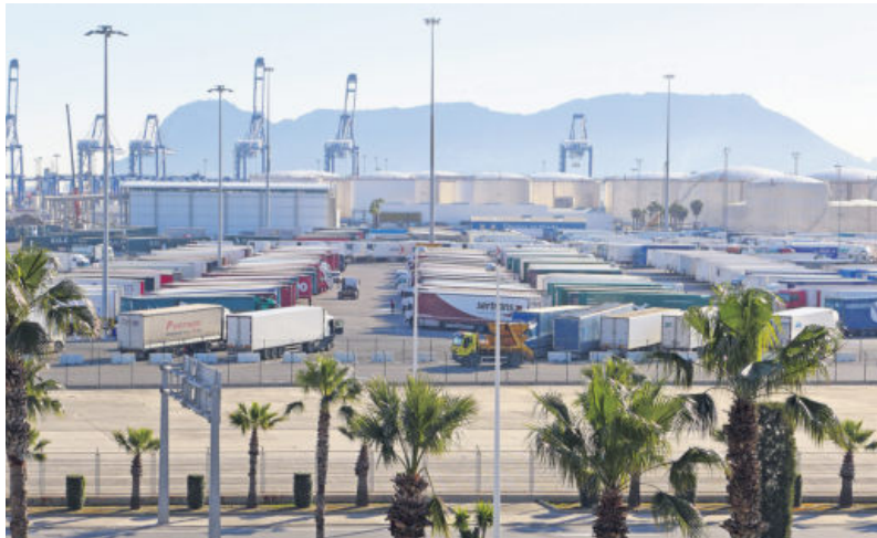
El puerto de Algeciras analiza espacios exteriores para descongestionar la dársena.
