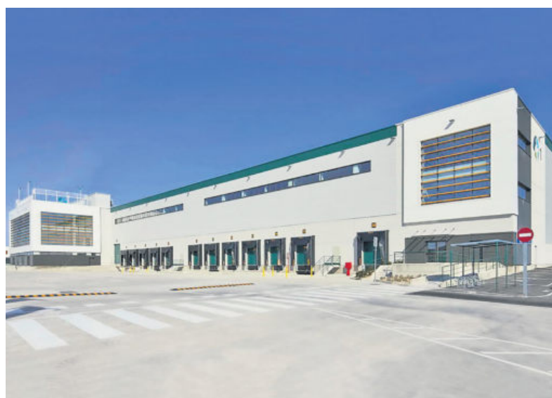
Areatrans opera una nave logística en Prologis Park San Fernando de Henares.
