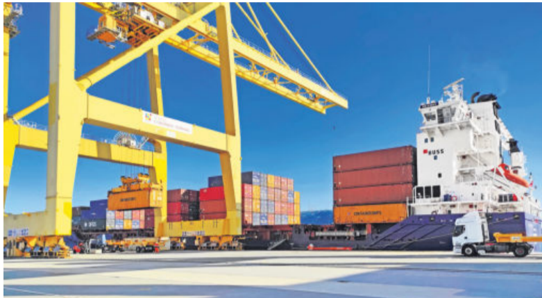
Imagen de las instalaciones de la terminal de contenedores que gestiona Yilport en Ferrol.
