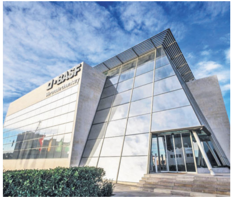
Oficinas de BASF en Tarragona.
