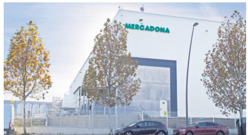
Nuevo bloque logístico de Mercadona en Getafe, en fase de construcción.
