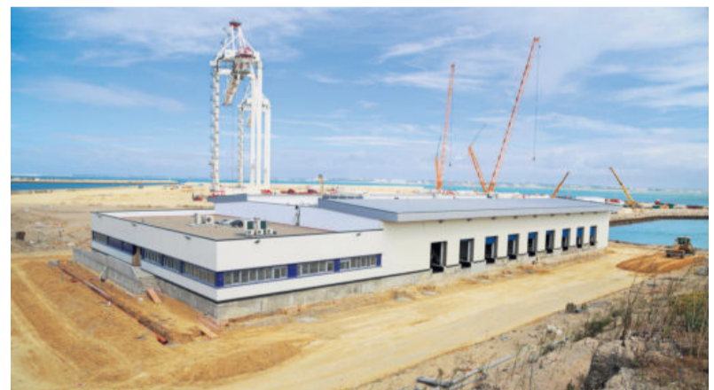
Imagen de las futuras instalaciones del PIF del puerto de Cádiz, actualmente en obras.
