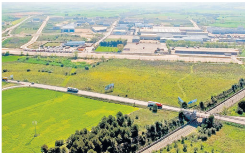
Vista aérea de la terminal formada por dos vías en ancho ibérico.
