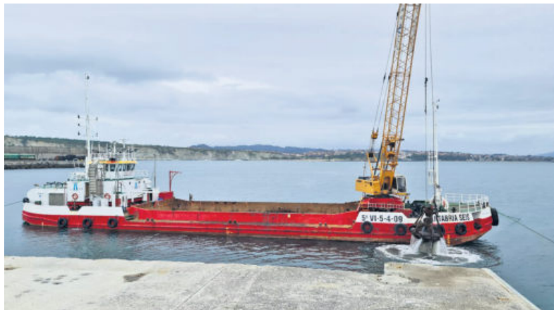
Imagen del inicio de los trabajos de dragado.
