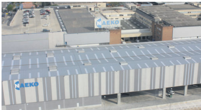
Las instalaciones centrales en Sant Boi de Llobregat (Barcelona).
