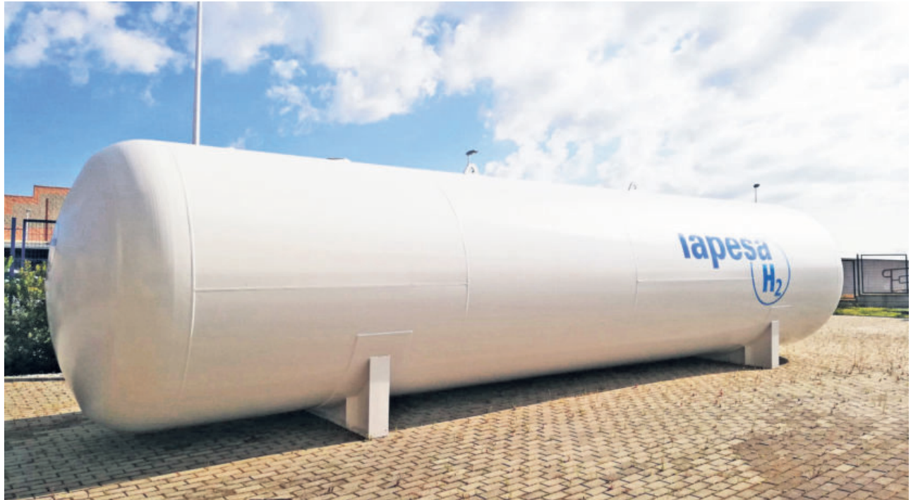
El puerto de Valencia tendrá a partir del próximo mes de enero de una hidrogenera / AUTORIDAD PORTUARIA DE VALENCIA
