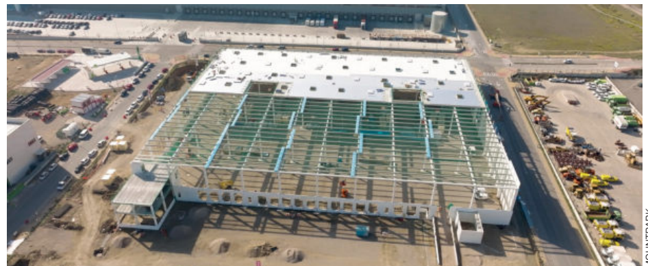
Proyecto de Mountpark en fase de construcción en Illescas.
