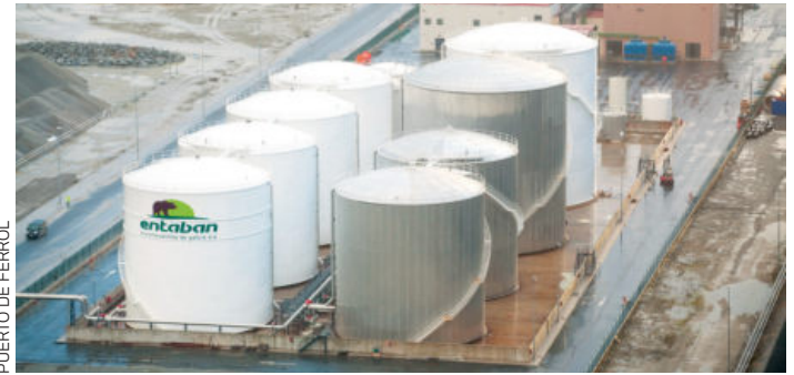
Instalaciones de Entabán Biocombustibles de Galicia en el puerto exterior de Ferrol.
