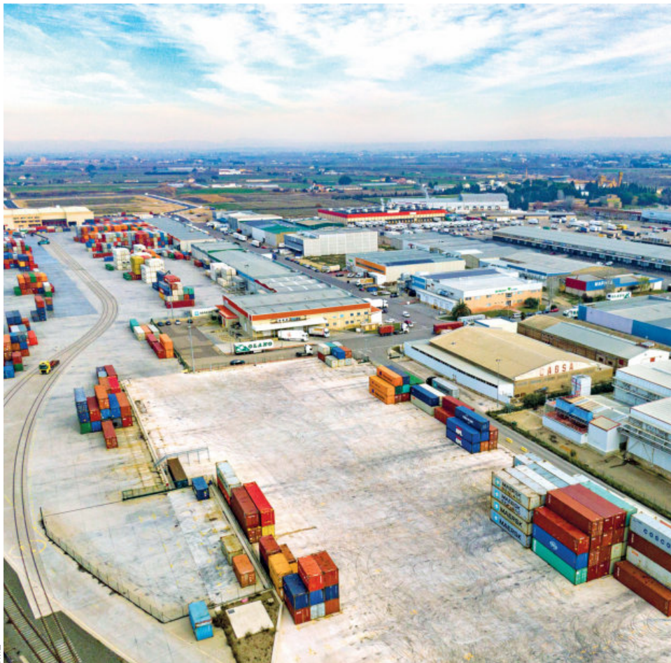
Vista aérea de la Terminal Marítima de Zaragoza (TMZ).
