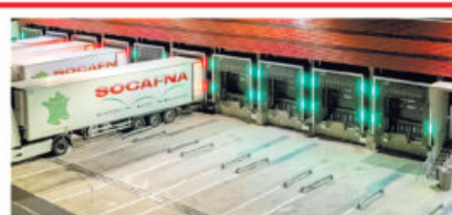
Abrigo hinchable con sistema de aviso LED Signal Shelter
