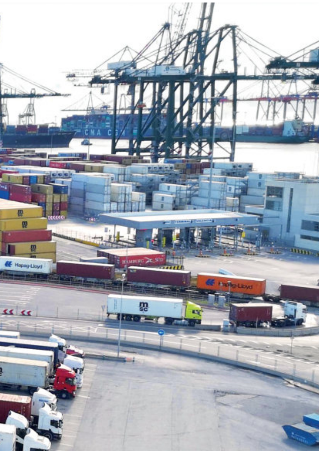
Las terminales están aumentando los espacios dedicados al reefer.
