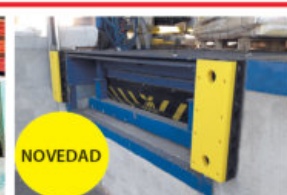
Topes de protección con amortiguación de impactos
