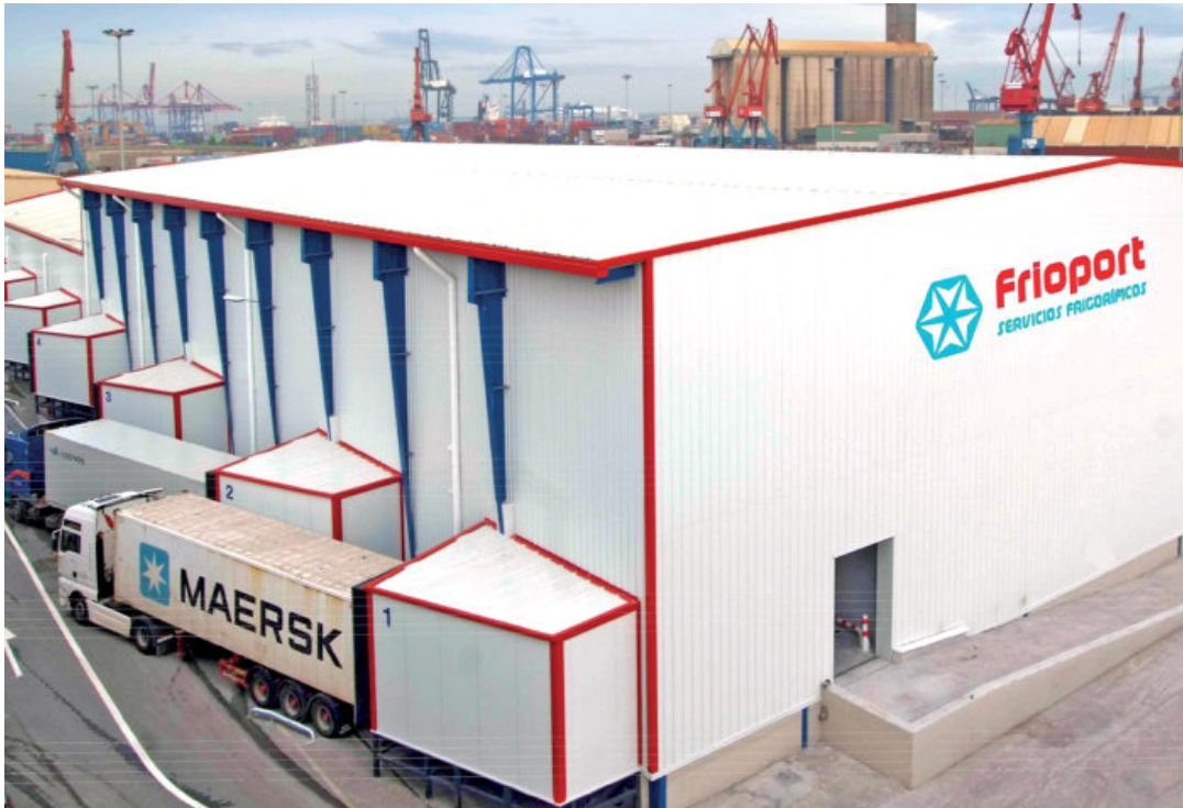
Vista de las instalaciones de Frioport en el puerto de Bilbao.
