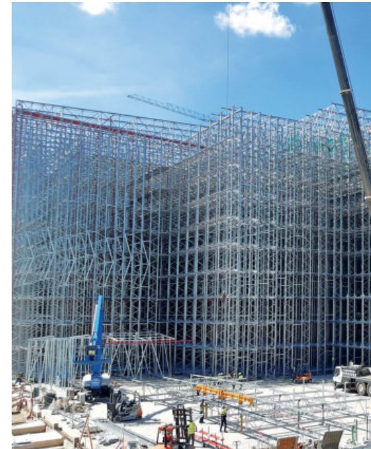
Almacén frigorífico en construcción de Virto en Funes (Navarra).
