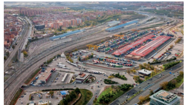
La terminal de Abroñigal cuenta con 230.000 m2 de superficie en pleno corazón de Madrid.
