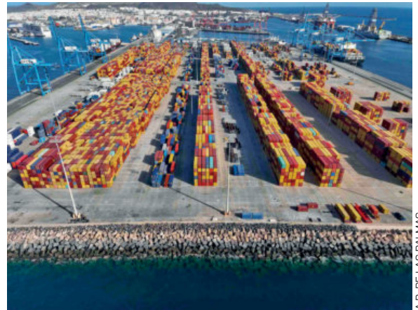
Terminal de OPCSA en el puerto de Las Palmas.
