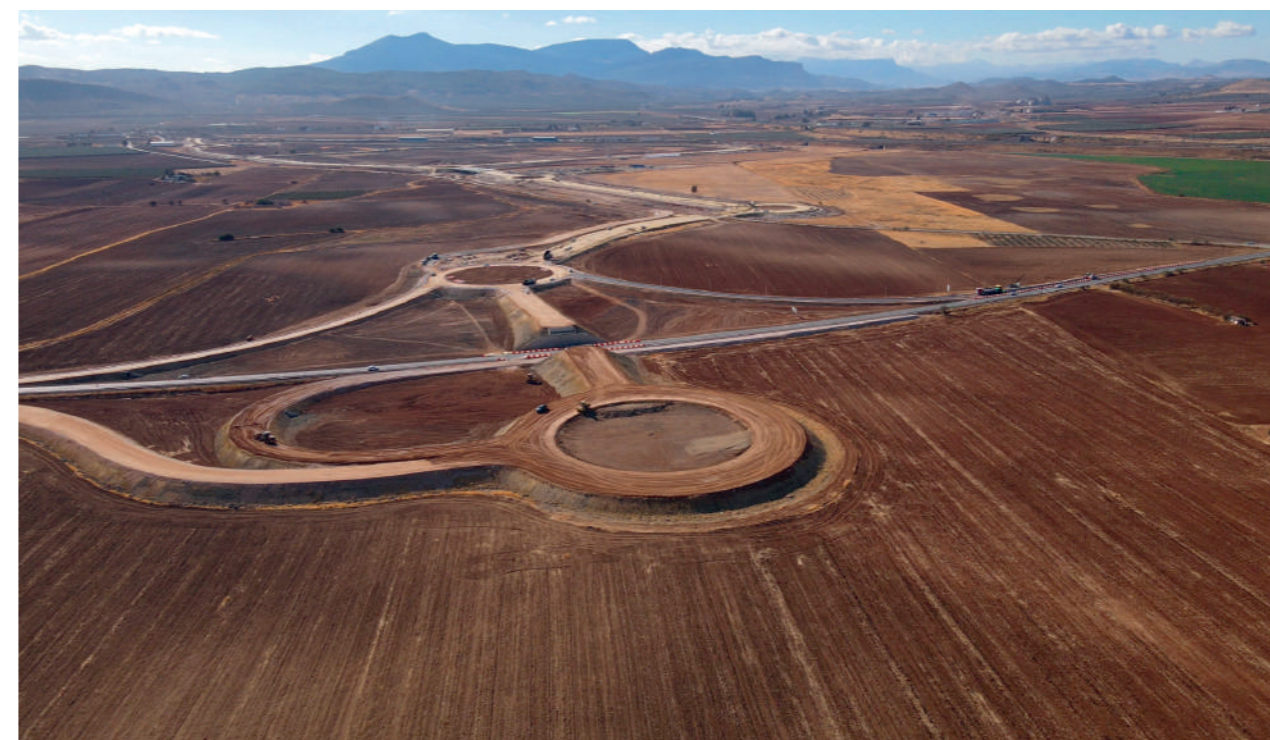
Estado actual de las obras
