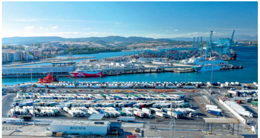
Terminal de Tráfico Pesado en Isla Verde Interior.
