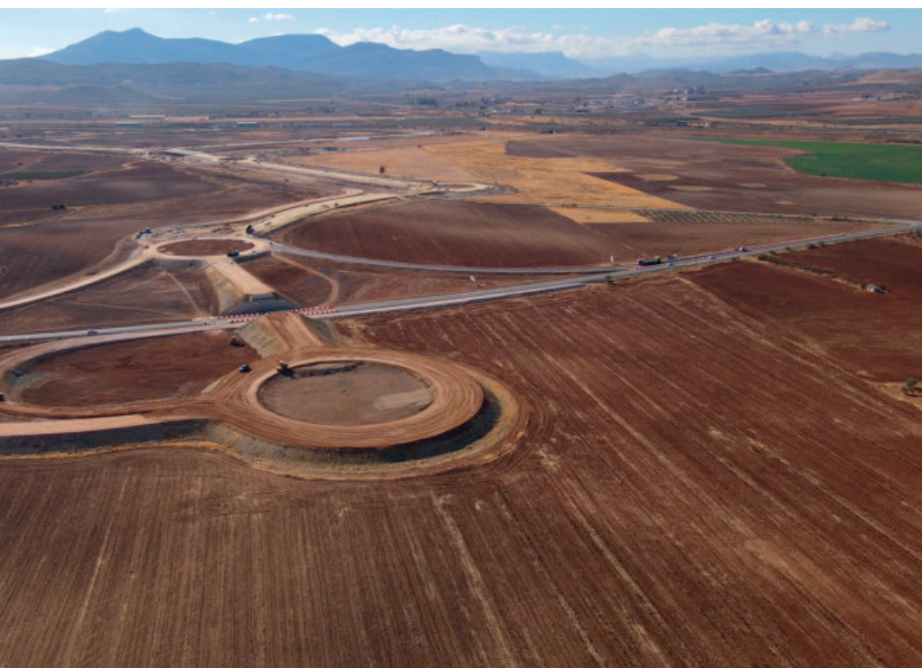
Estado actual de las obras
