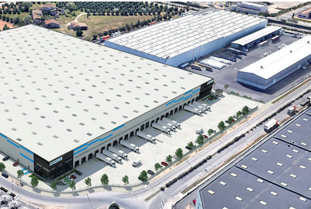
Nave logística que comercializa CBRE en Constantí.
