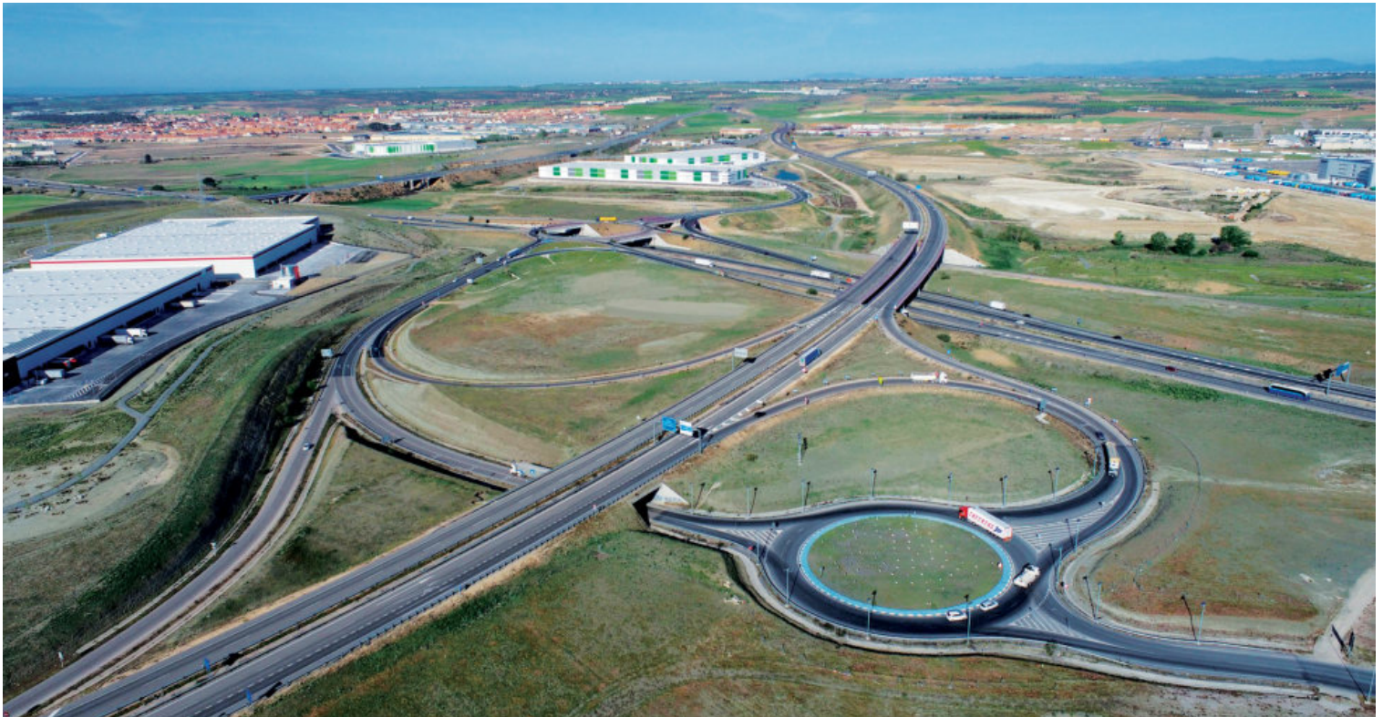
Imagen de la Plataforma Central Iberum Multimodal en Illescas (Toledo), que en 2022 obtuvo la certificación medioambiental con el sello BREEAM Very Good.
