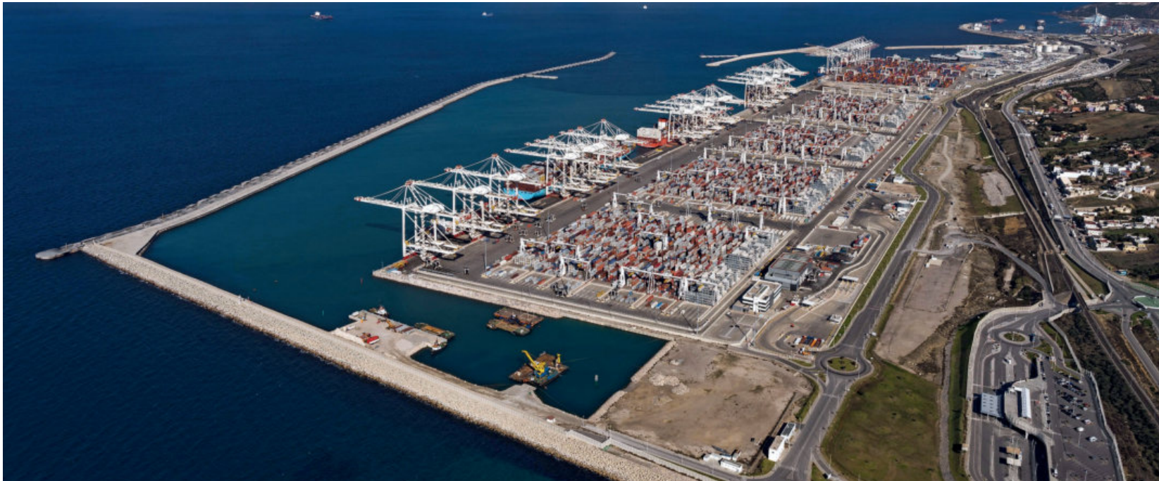
Imagen de la terminal automatizada de APM Terminals en la segunda fase del puerto marroquí de Tánger-Med.
