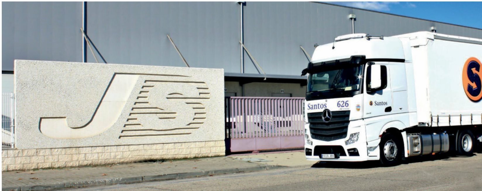
Imagen de archivo de las instalaciones centrales de Grupo Logístico Santos en Cabanillas del Campo (Guadalajara).
