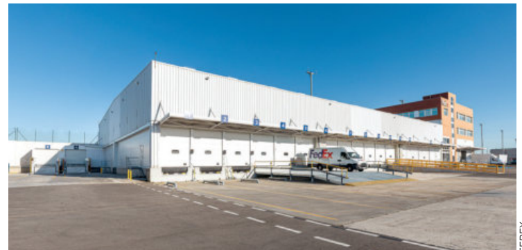
Las instalaciones cuentan con dos cámaras de refrigeración y depósito aduanero.
