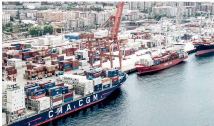
Instalaciones de Termavi en el puerto de Vigo.
