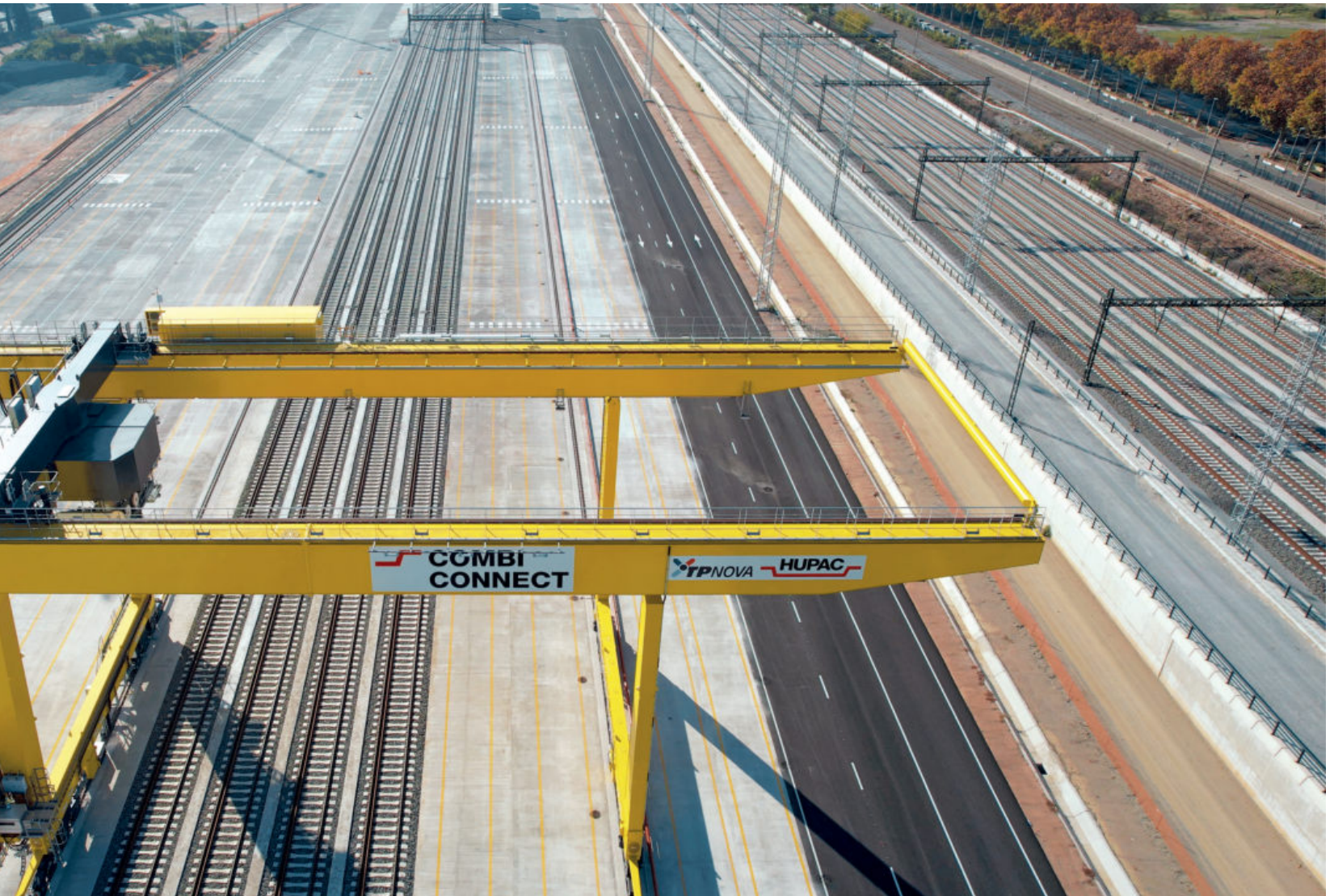
Image of Adif's La Llagosta terminal (Barcelona).
