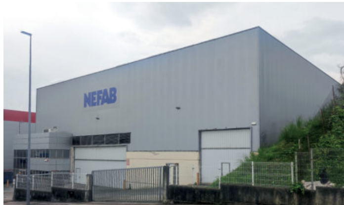
Imagen de las nuevas instalaciones en Gallarta.
