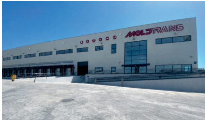
La instalación contará con 39 muelles para camiones.
