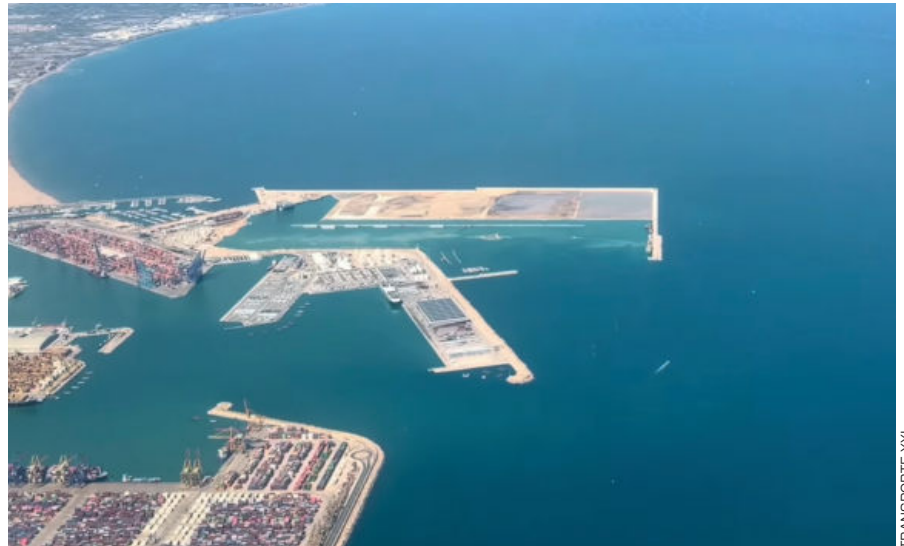
Imagen aérea del estado de las obras de la futura terminal de TIL a finales del pasado mes de abril.
