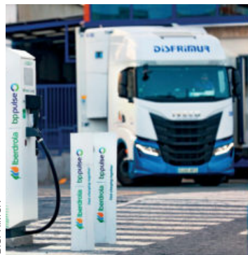
Estación de recarga de Disfrimur.
