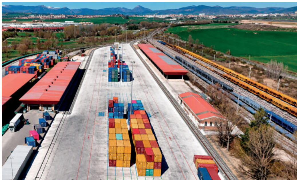
Imagen de la terminal de Noáin, recientemente ampliada.
