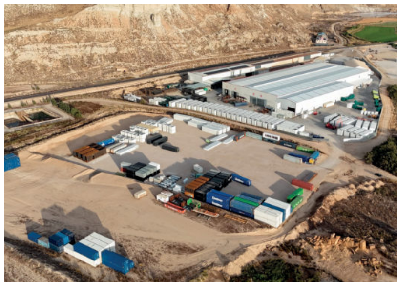
Vista de la ampliación de las instalaciones de Eurocontainer en la localidad zaragozana de Remolinos.
