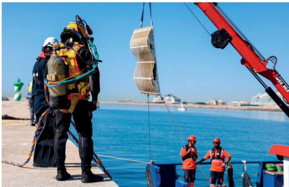
Operativa de instalación de una Life Boosting Unit del RegenPorts.
